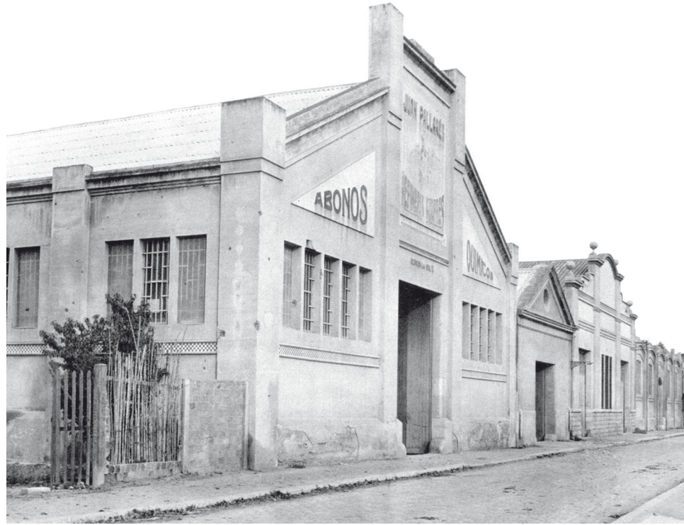
Antigues instal·lacions del carrer Torres Jordi a Tarragona
